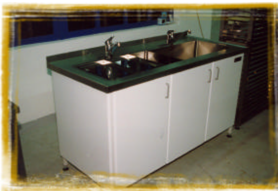
Pomivalno korito z dvema enorocnima pipama in vgrajenim dvojnimi odcejalnikom in izločevalcem blata.
